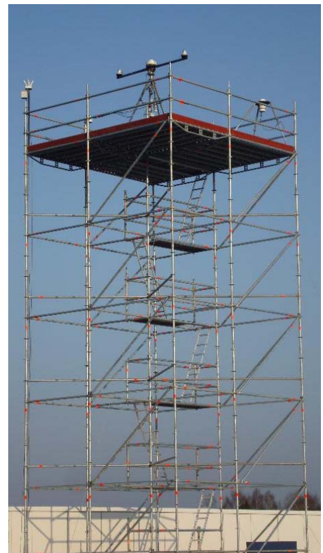
Figure 26 : Vue générale de la station de Redu, située au sommet d'une tour de 18 m sur le site de l'Euro Space Center.
